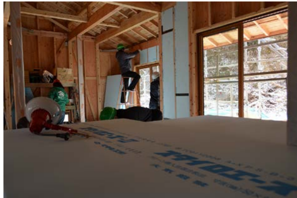
(寄贈品を使った施工作業の様子 © Habitat for Humanity Japan)
